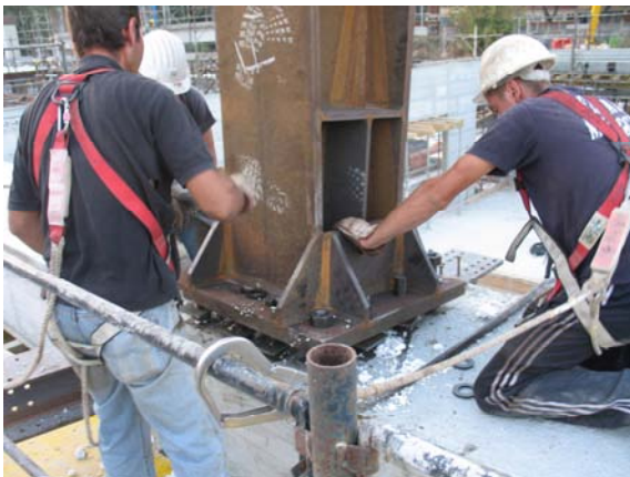
Collegamento piedritto in acciaio del portale alla piastra di base
