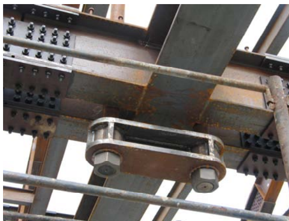
Pendini di supporto dei solai - Dettaglio
