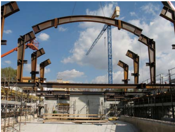
Posa della trave curva del portale in acciaio
