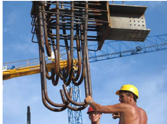
Posa elemento di collegamento tra struttura in c.a. e portali in acciaio
