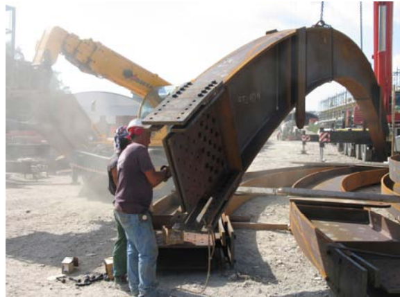
Tiro della trave curva del portale in acciaio
