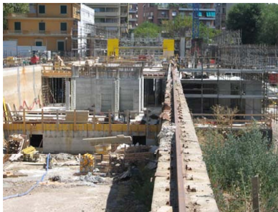
Opere in c.a. – Setti e pilastri
