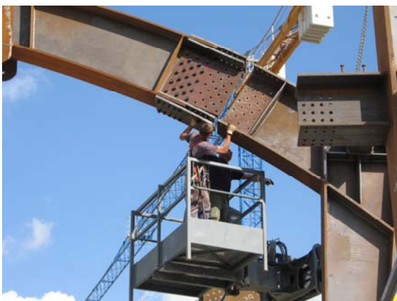
Ancoraggio della trave curva del portale in acciaio
