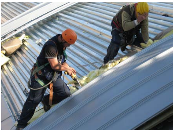
Posa del manto di copertura
