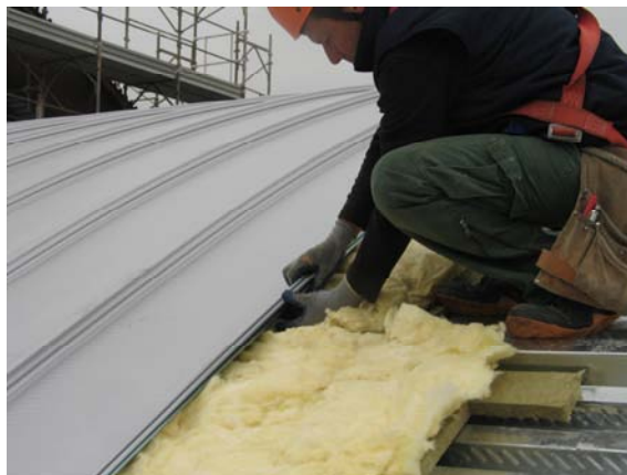
Posa dell'isolamento e del manto di copertura
