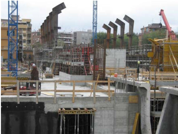
Piedritti dei portali in acciaio in fase di montaggio
